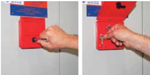
▼ V.C. 2. Cofre de llaves apertura de cuarto o armario de maniobra. ▼ V.C. 3. Llave de cuarto o armario + útil desbloqueo de puerta.
