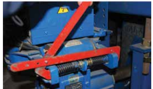
▼ VE. 44, 45 y 46. Máquina tractora con palanca de freno para montaje ocasional
