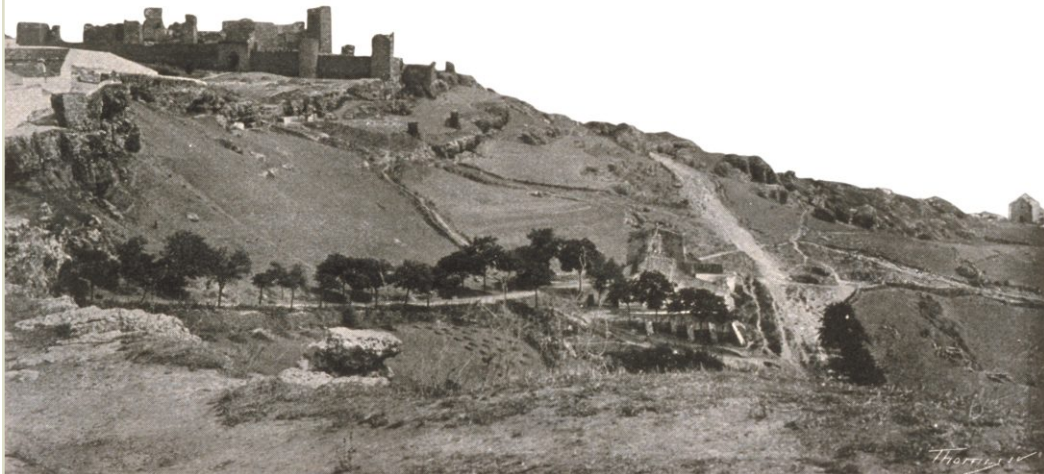
Castillo de Carmona, ejemplo de la red de fortificaciones fronterizas que jalonan el territorio de la provincia.
